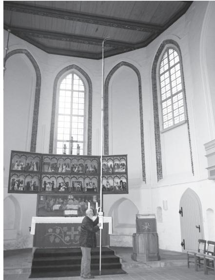
Bild 5. Injektion und Probenahme in großen Höhen mittels Teleskopstange.
